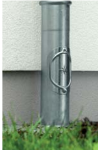
das Standrohr gutter pipe ماسورة أرضي لولة عمودي
