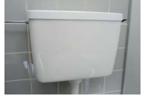
der Aufputzspülkasten external (flushing) cistern صندوق ماء الكسح العلوي مخزن آب سیفون
