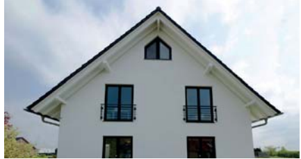
das Giebedach pitched roof سطح جملون سقف شيروانی
