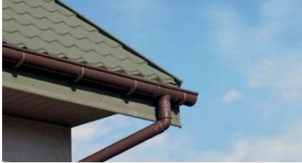
die Dachrinne (eaves) gutter مزاراب سقف ناودان سقف
